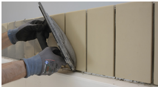
Påføring af Alfix IndustryFuge - CeraFill 18
