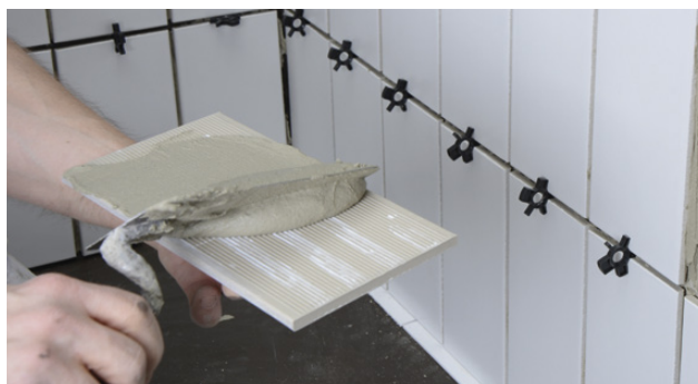
Påføring af skrabelag på flisens bagside
