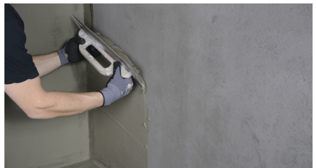
Påføring af Alfix 2K Tætningsmasse - porefyldende lag
