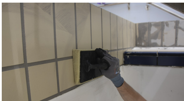
Fliserne afvaskes med hårdtopvredet viskosesvamp
