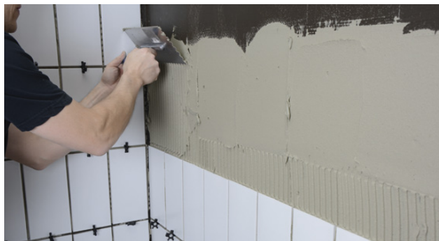
Påføring af fliseklæber med tandspartel
