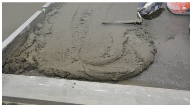
Udlægning og komprimering på gulv
