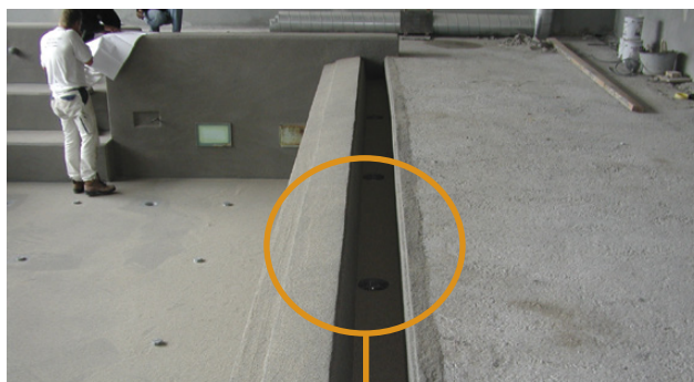
Montering af Alfix VT-Tætningsbånd
