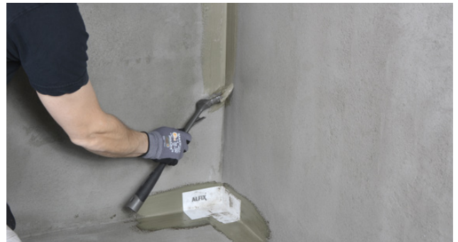
Montering af Alfix VT-hjørne i tætningsmasse
