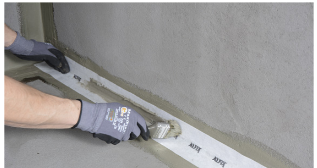
Montering af Alfix VT-tætningsbånd
