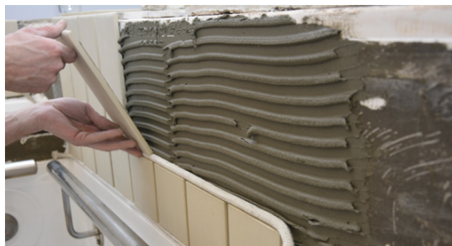
Montering af fliser
