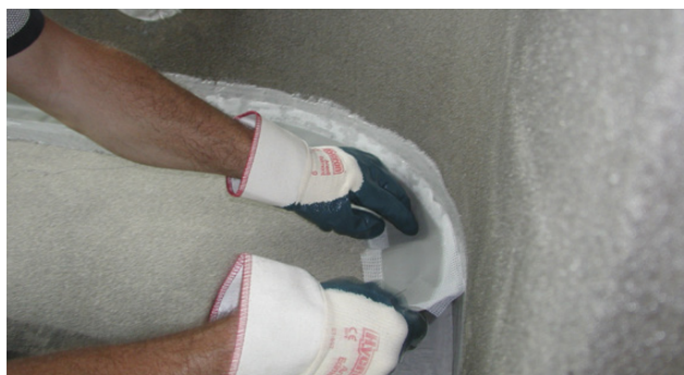
Montering af Alfix VT-Tætningsbånd
