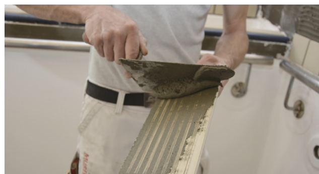
Påføring af skrabelag på flisens bagside
