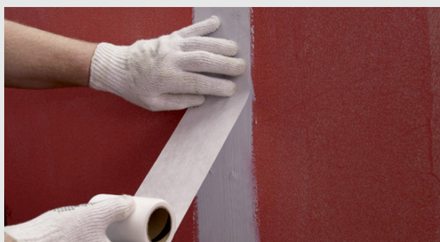
Forstærkning af samling med armeringsvæv
