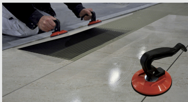
Lægning af fliser ved hjælp af sugekop
