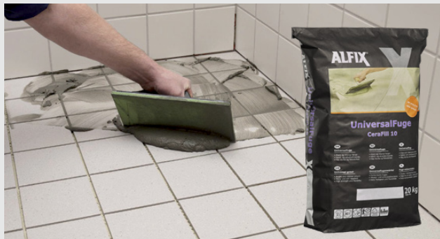
Påføring af cementbaseret fugemasse på gulv, f.eks. UniversalFuge - CeraFill 10
