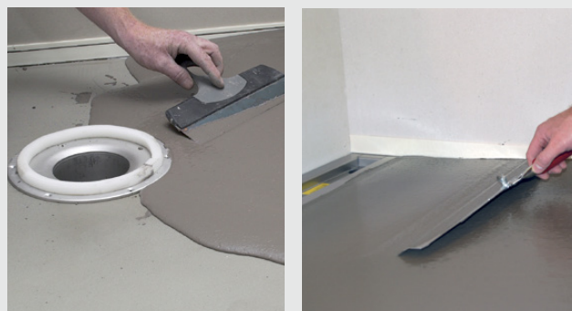
Opbygning af fald med spartelmasse, PlaneMix 60
