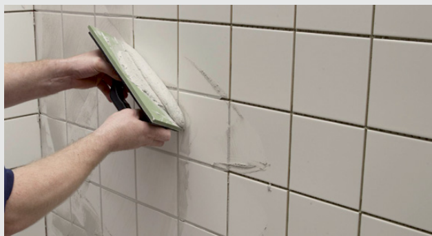
Påføring af cementbaseret fugemasse på væg
