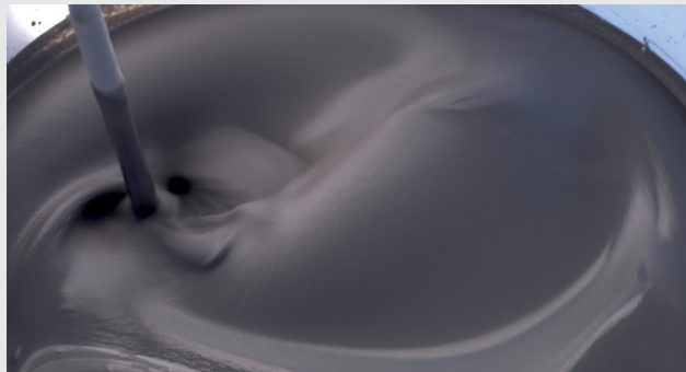
Oprøring af spartelmasse
