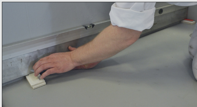
Markering af vandret linie med retskinne
