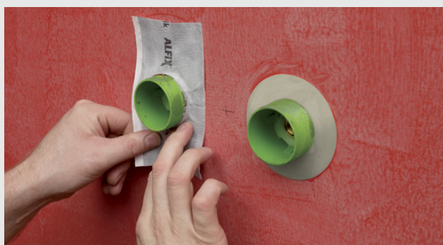
Montering ved rør
