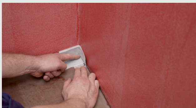
Montering af Seal-Strip i hjørne
