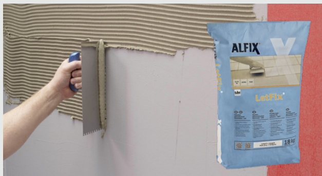
Påføring af fliseklæber, LetFix
