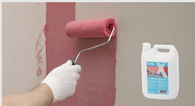
Primning på væg med rulle, VådrumsPrimer
