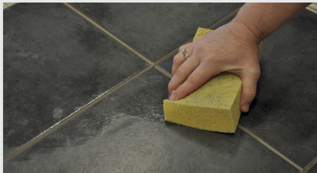
Overfladen fugtes
