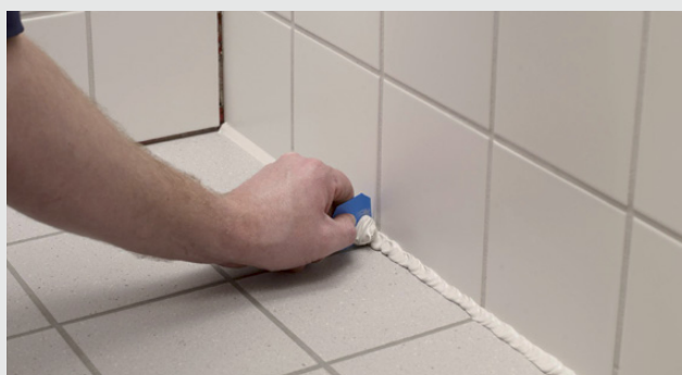
Overskydende fugemasse fjernes med glittespartel
