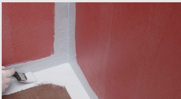
Påføring med pensel
