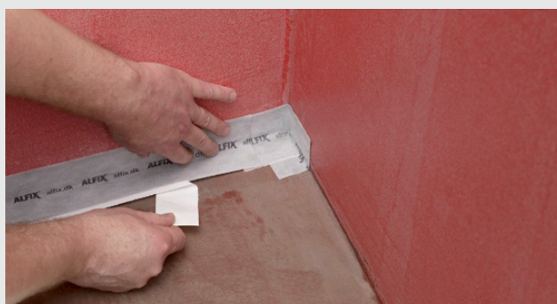
Montering i overgang væg og gulv
