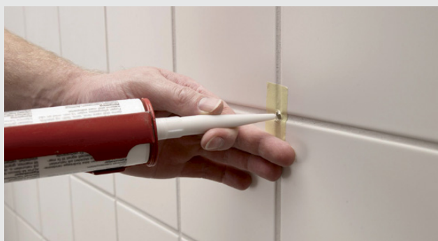
Fyldning af hullet med silikone
