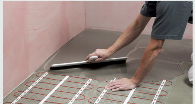
Fordeling af spartelmasse
