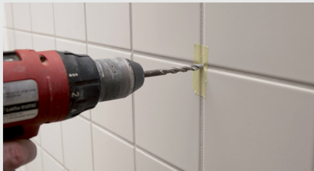
Boring af hul
