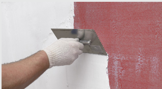
Påføring med tandspartel...
