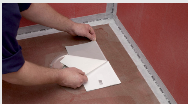
Montering af afløbsmanchet
