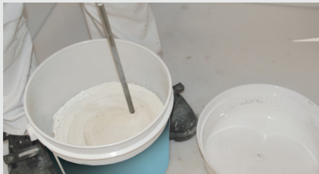
Blanding af binder og cement
