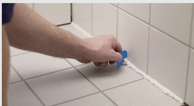
Overskydende fugemasse fjernes
