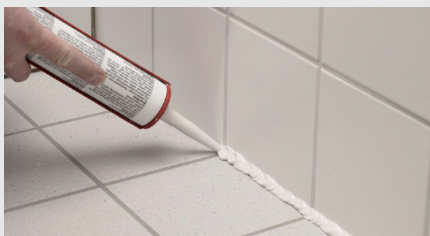
Fyldning med siliconebaseret fugemasse
