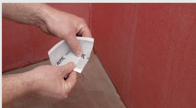
Tilpasning af selvklæbende hjørne
