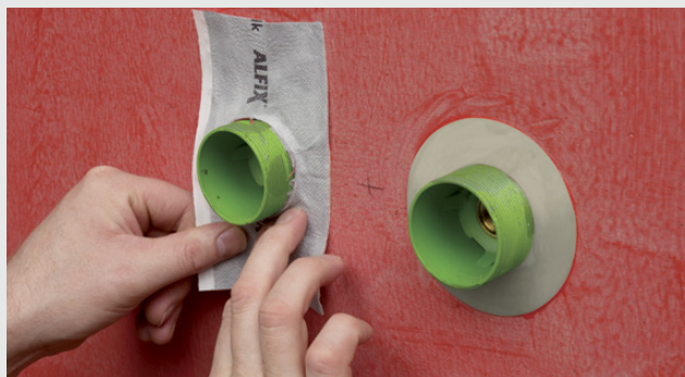
Montering ved rør
