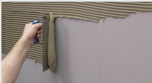
Påføring af fliseklæber
