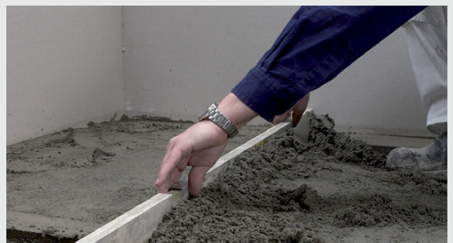
Udstøbning på træbjælkelag
