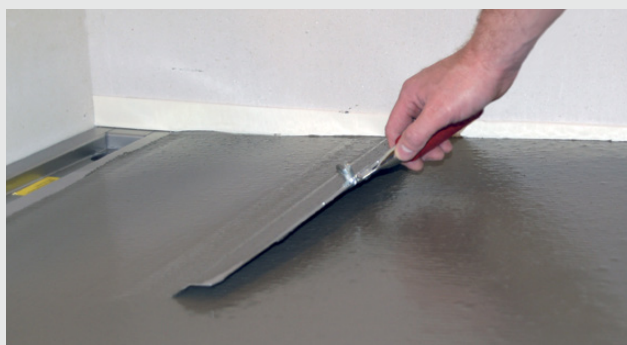
Faldopbygning ved vægnært gulv afløb
