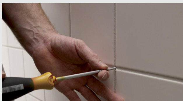
Montering af skrue efter fyldning med silikone
