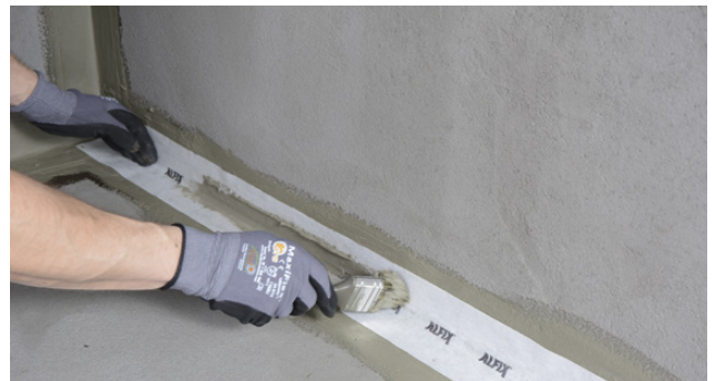
Montering av Alfix VT-tetningsbånd
