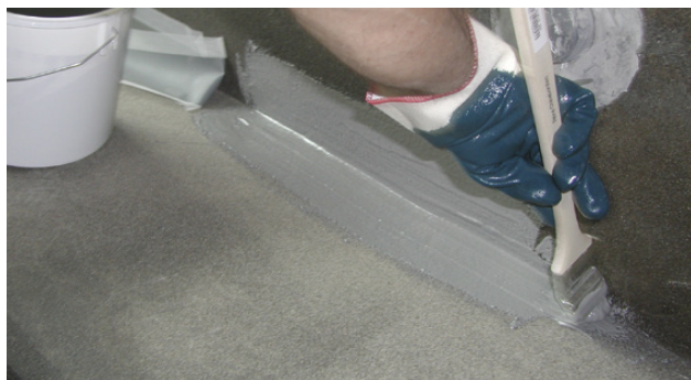
Påføring av Alfix Epoxy Membran
