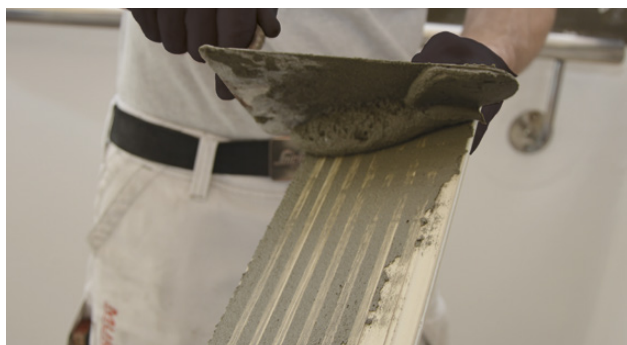
Påføring av skrapelag på baksiden av flisen
