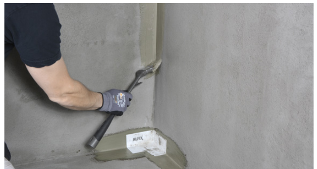
Montering av Alfix VT-hjørne i tetningsmasse
