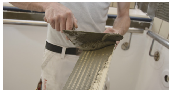
Påføring av skrapelag på baksiden av flisen
