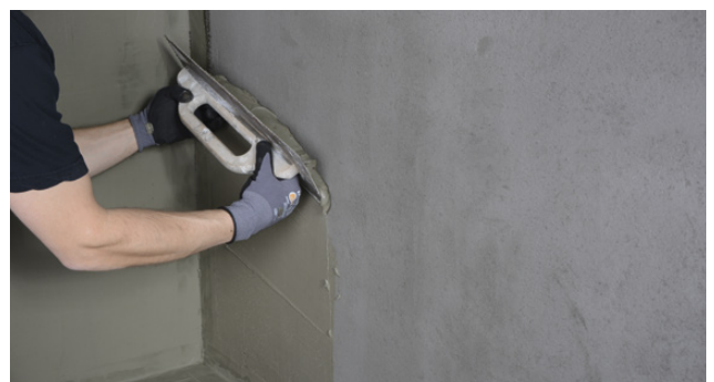
Påføring av Alfix 2K Tetningsmasse – porefyllende lag
