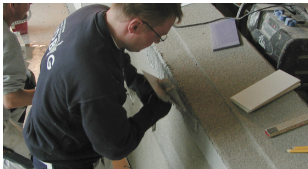
Påføring av Alfix EpoxyFuge 20 med tannsparkel
