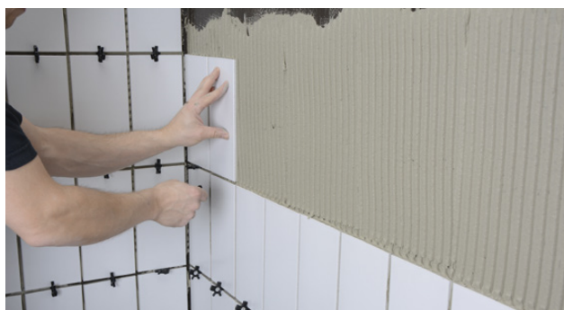
Montering av fliser
