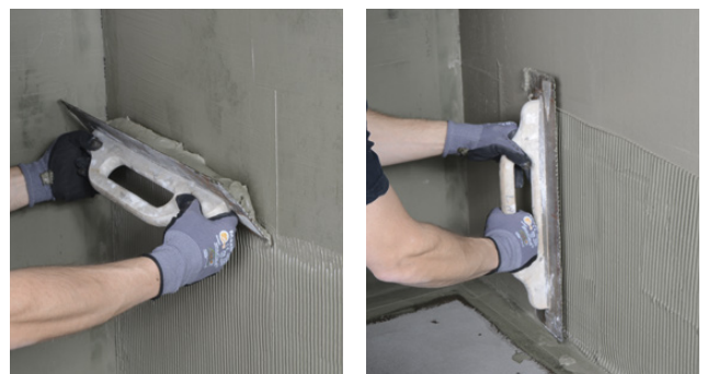
Påføring av 2K Tetningsmasse og glatting
