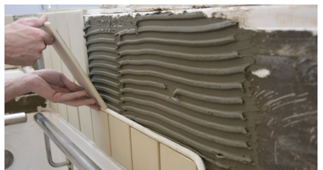
Montering av fliser
