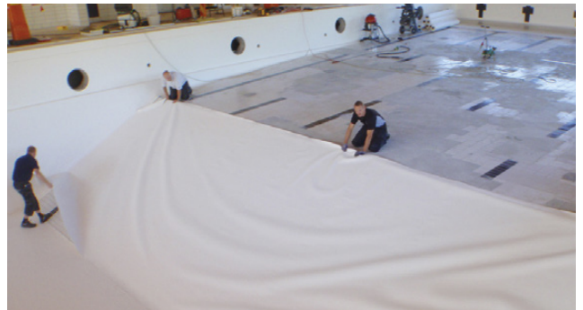
Installering av PVC folie
