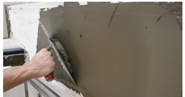
Påføring av kontaktlag
