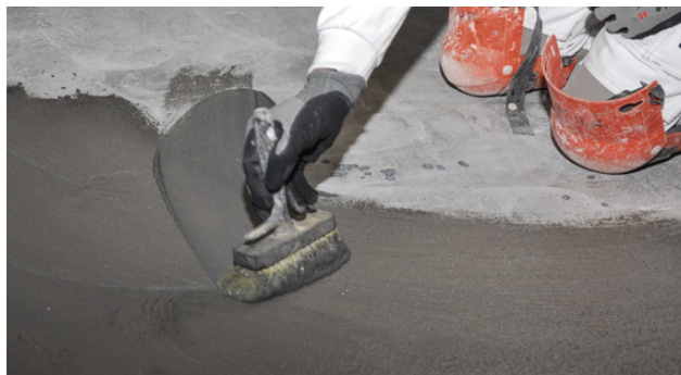
Legging av grunningslag
