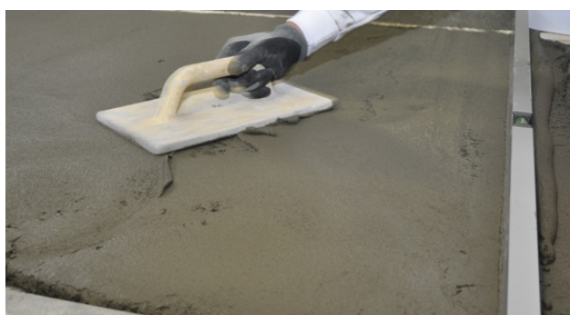
Bearbeiding med pussebrett
