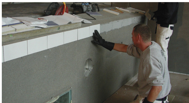
Montering av fliser i fuktig lim
