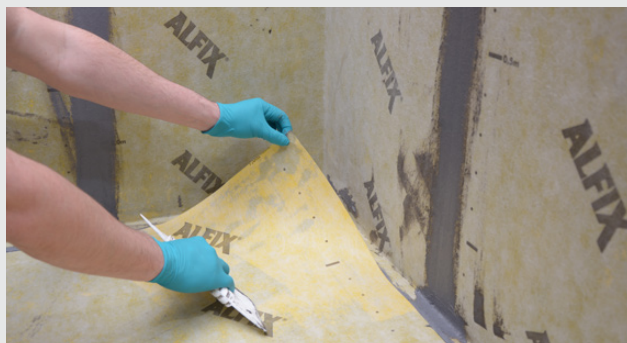
Montering av banemembran på gulv
