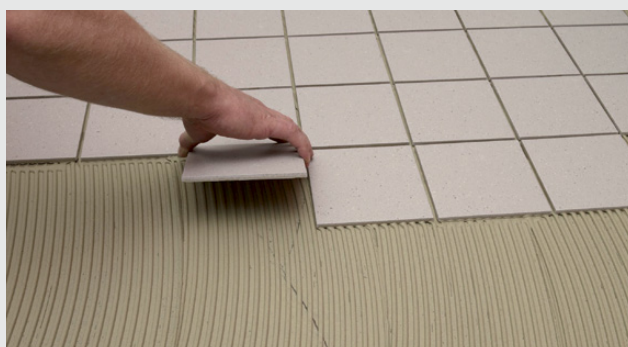
Montering av fliser på gulv
