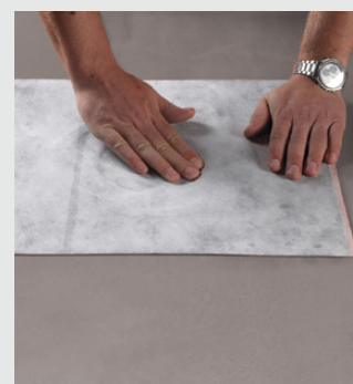
Montering av slukmansjett Seal-Mat 40x40 cm eller type H
