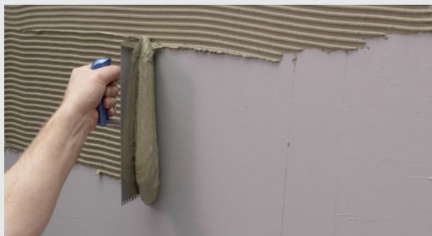
Påføring av flislim
