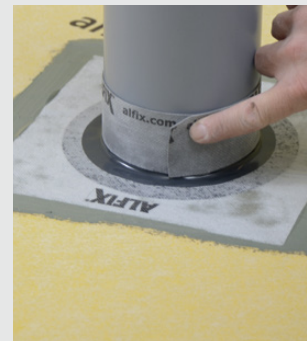
Forsterkning med Seal-Strip ved vannbelastede rør
