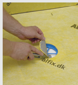
2: Utskjæring med skabelon ved slukmansjett Type H
