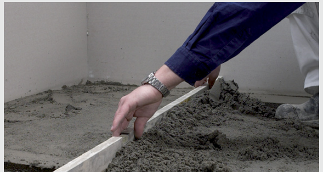
Støp på trebjelkelag
