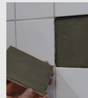
Tettningsmassen påføres underlaget, og flisen monteres
