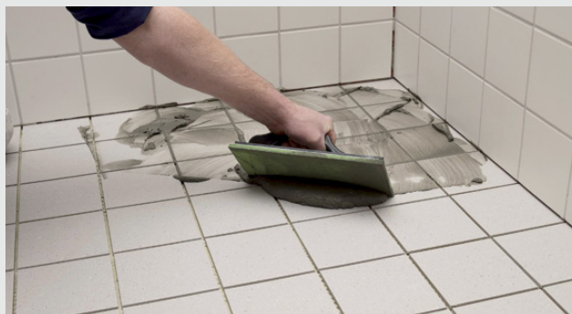
Påføring av sementbasert fugemasse
