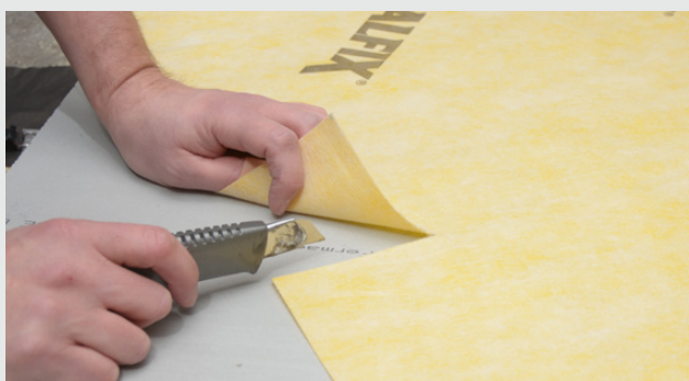
Metode 2: Skjær 10 cm i vegg-/gulvvinkelen der banemembranen monteres rundt hjørnet
