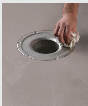
Rengjøring av slukflensen
