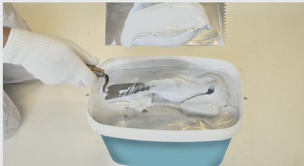
Tetningsmasse klar til påføring
