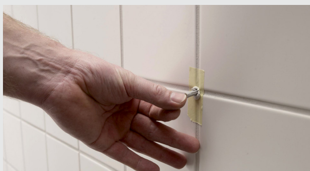
Montering av ekspansjonsplugg
