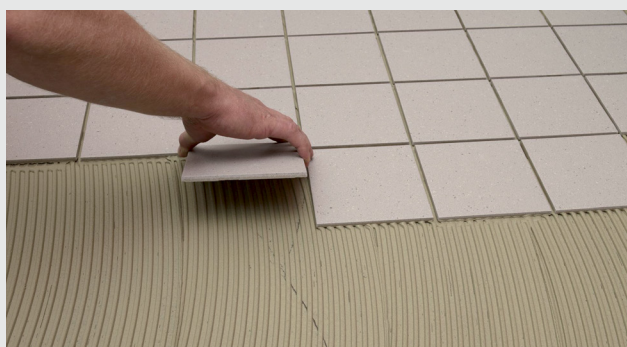
Montering på gulv
