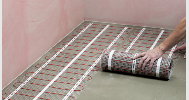
Utlegging av varmematter
