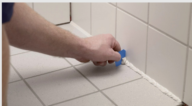
Overflødig fugemasse fjernes
