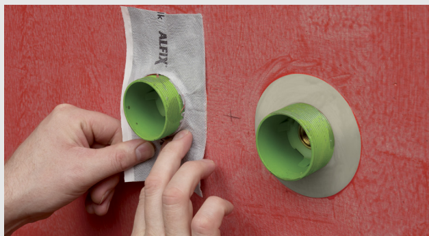
Montering ved rør
