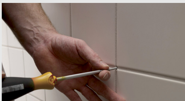
Montering av skrue etter fylling med silikon
