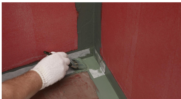
Montering av VT-tetningsbånd og hjørner i tetningsmasse
