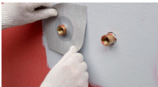
Montering af VT- rørmanchet
