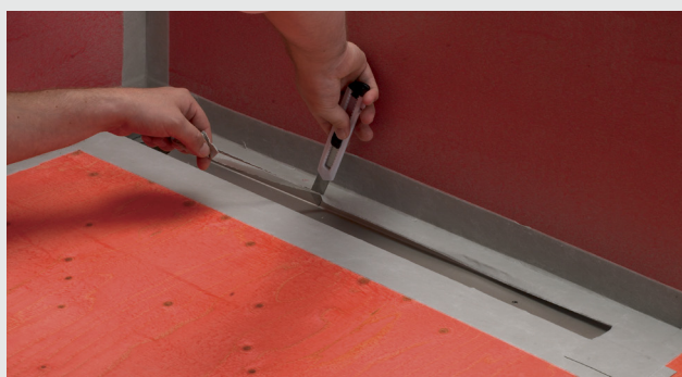
Renskjæring av kanter ved design avløp
