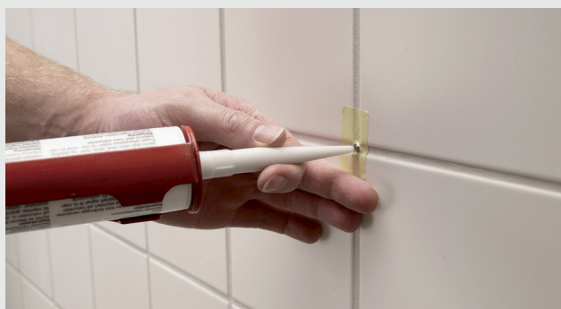
Fylling av hullet med silikon
