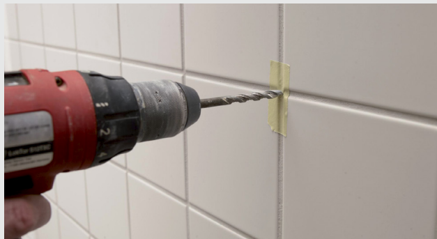
Boring av hull
