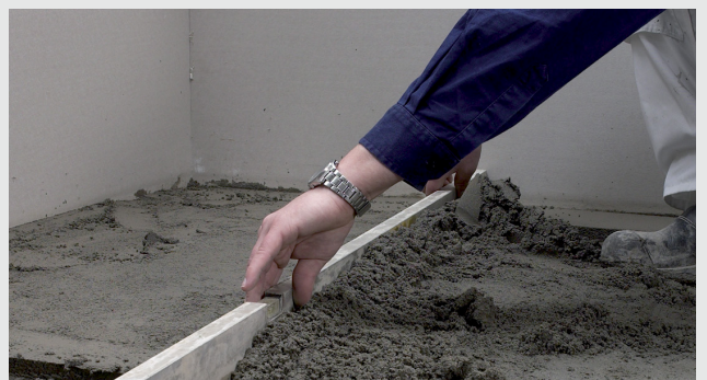
Uttøping på trebjelkelag
