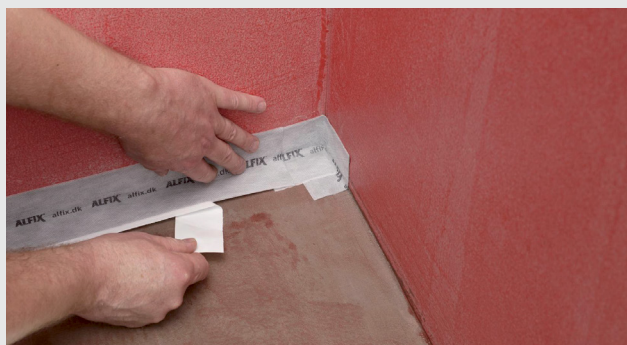
Montering i overgang mellom vegg og gulv
