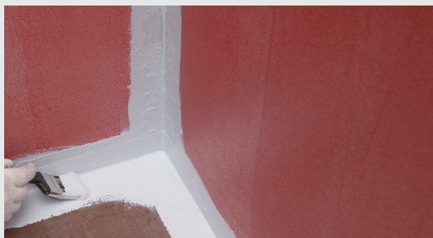
Påføring med pensel
