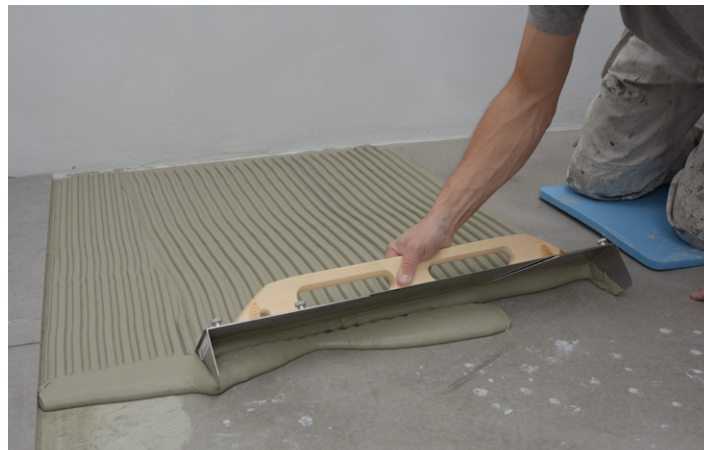
Applicering av fästmassa på underlaget
