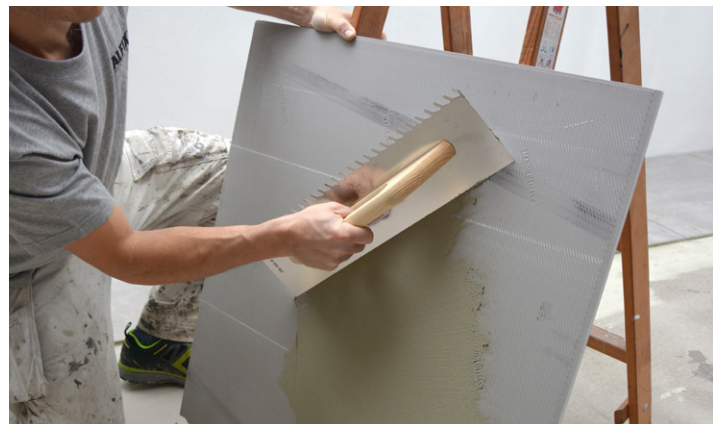
Applicering av fästmassa på plattans baksida (dubbellimning)
