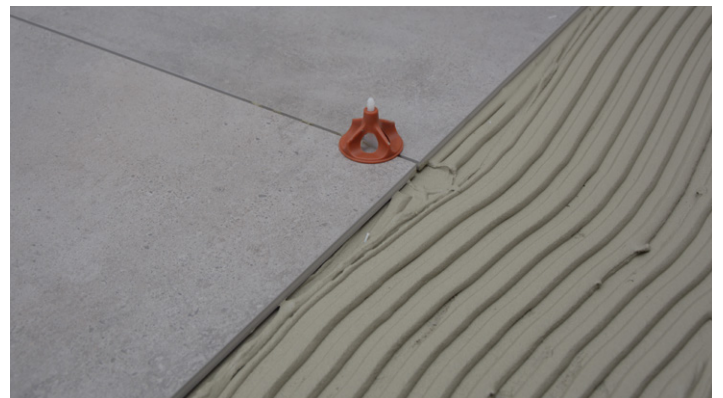
Exempel på nivelleringsystem för plattor
