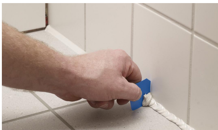
Överskjutande fogmassa skrapas bort
