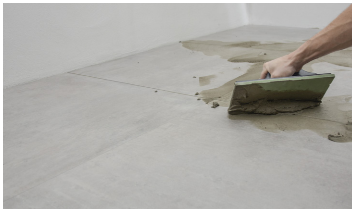
Påföring av fogmassa
